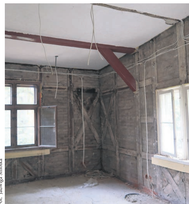
Remont Szkoły Muzycznej w Działdowie
