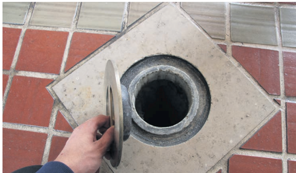
Kanały grzewcze, którymi wpuszczano ciepło do Refektarza Wielkiego na Zamku w Malborku
