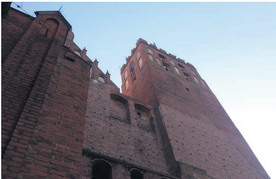
Ceglany monument w Kwidzynie
